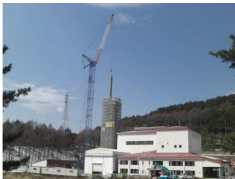
内筒解体状況
