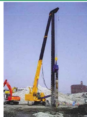
ケーシング掘削状況写真(例)
