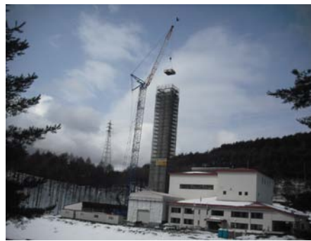
外筒解体状況
