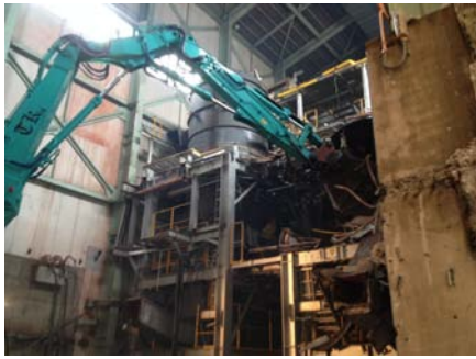
焼却施設解体状況
