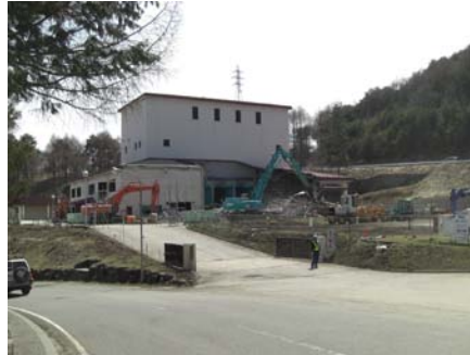
工場棟建屋解体状況
