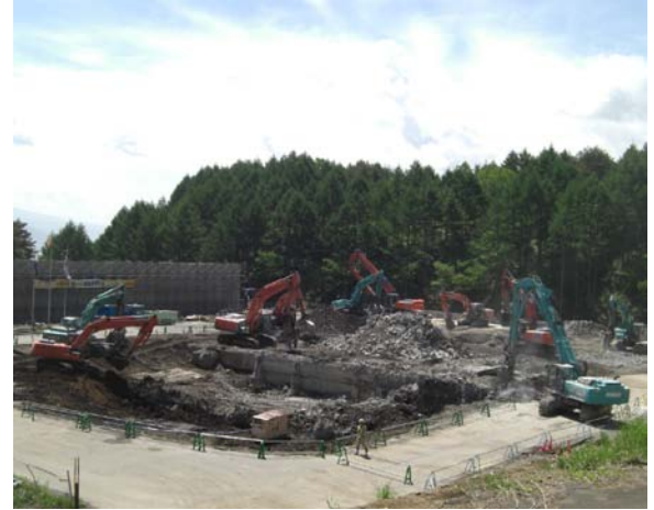
工場棟地下部解体状況
