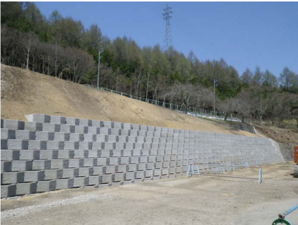
植生ブロック施工完了
