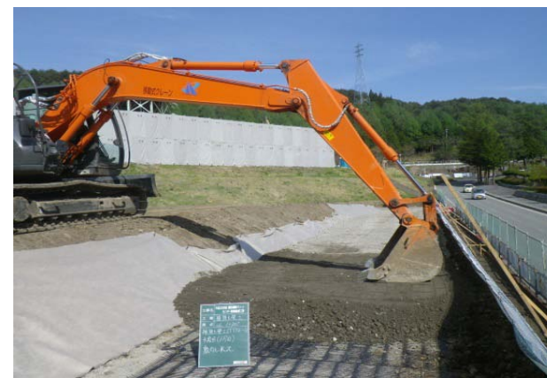
盛土材敷均し
