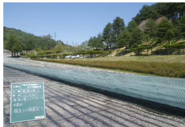
ジオグリッド敷設
