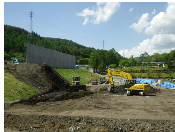
盛土工施工状況
