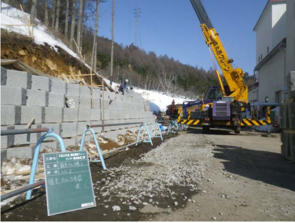
植生ブロック布設状況
