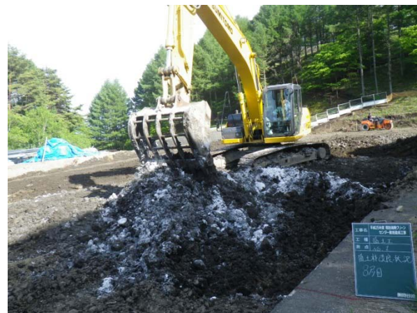
改良材混合状況
