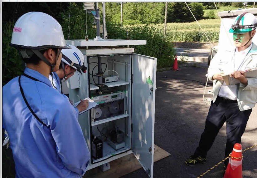
調査の様子 (H30.8.9 樋沢地区調査地点)
