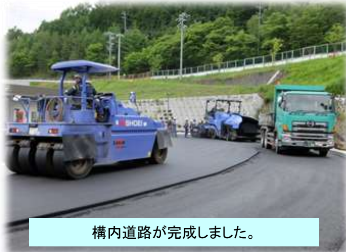
舗装工事 施工状況
