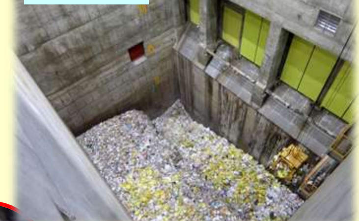
ごみピット状況
