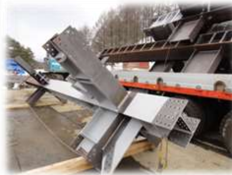
鉄骨搬入状況
