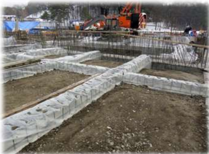
A工区② 埋戻状況
