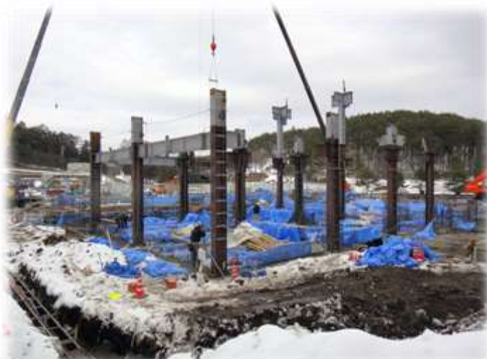
鉄骨建方状況
