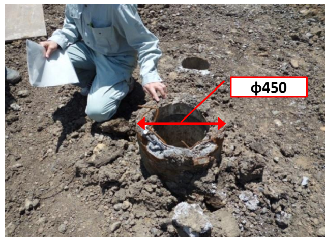
岡谷市旧清掃工場の既存基礎杭
