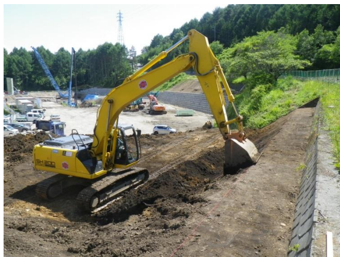
切り土作業状況
