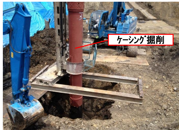
既存基礎杭撤去状況
