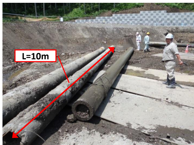
引抜かれた既存基礎杭
