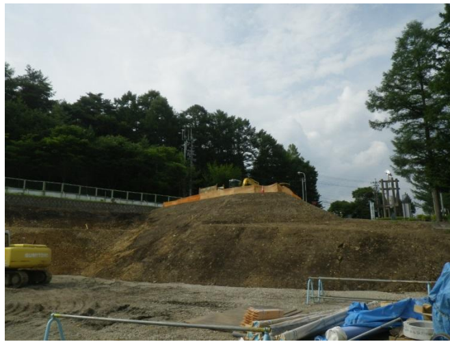
のり面整形・整地完了
