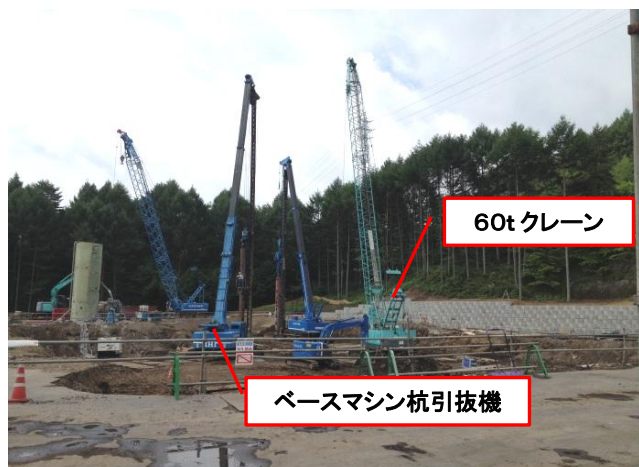
既存基礎杭撤去状況
