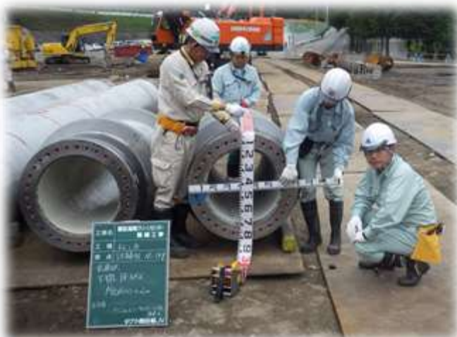
杭材料受入検査
