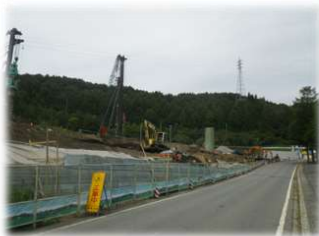
補強土壁状況
