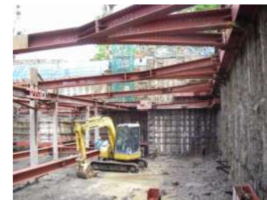
山留・掘削工事(イメージ)
