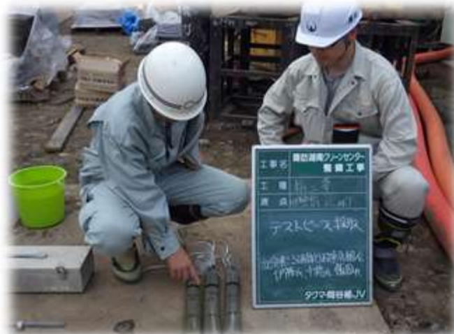
根固め液(セメントミルク)の調合確認
