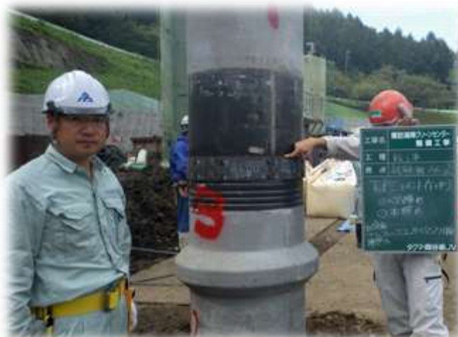
杭接合部(ジョイント)の確認
