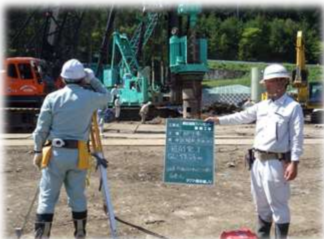
掘削深度の確認
