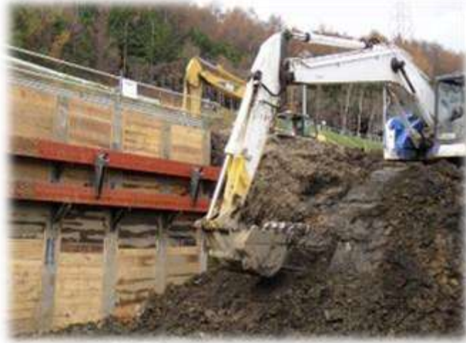
掘削工事状況
