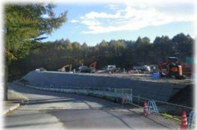
補強土壁施工状況
