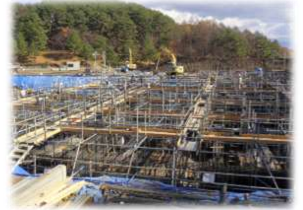
基礎躯体工事
