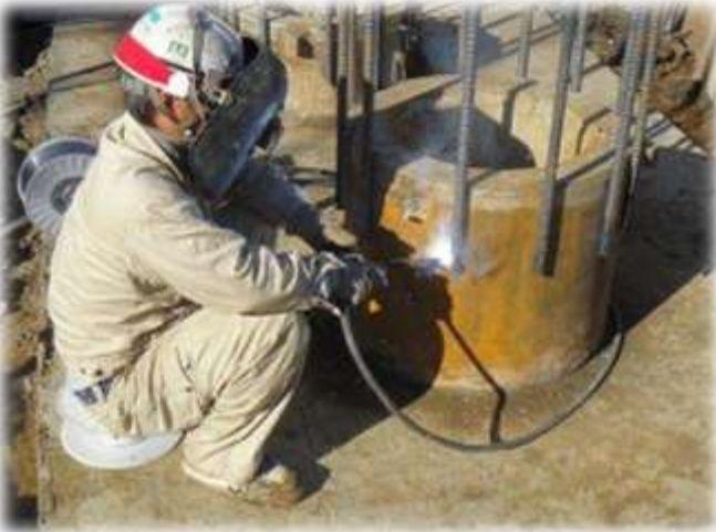
杭頭補強筋 溶接状況
