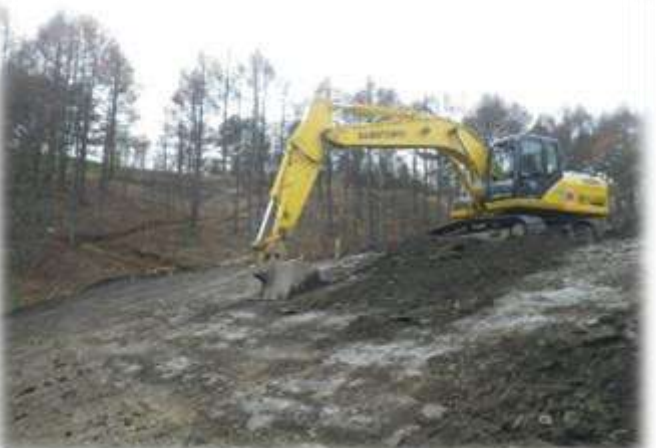
盛土(法面整形)状況
