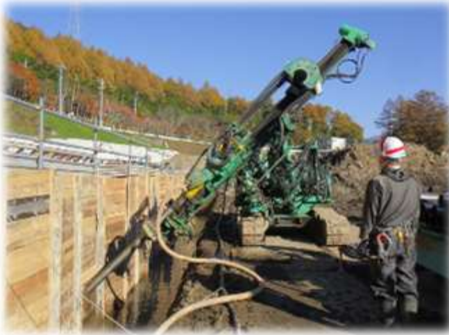
アースアンカー打設状況
