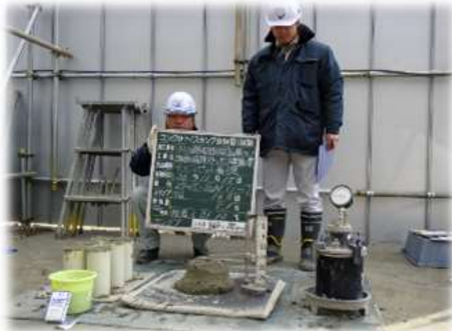
コンクリート打設前検査 実施状況
