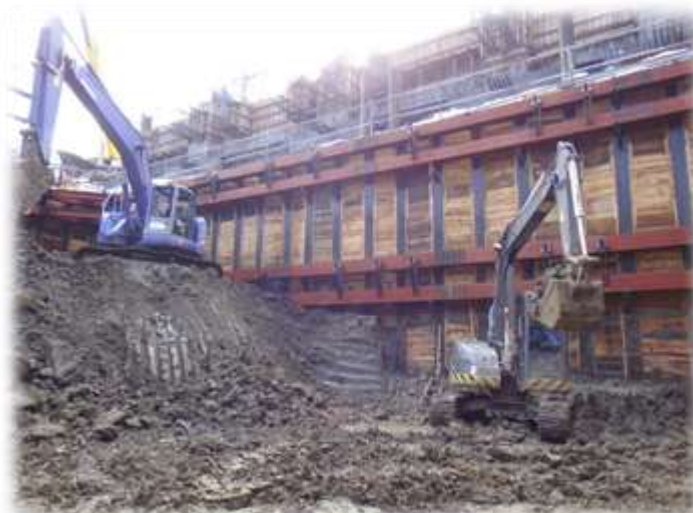
B工区 地下掘削状況
