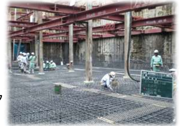
地下コンクリート躯体工事(イメージ)
