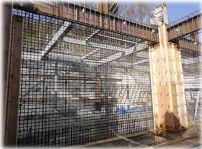
A工区①② 1階壁配筋状況
