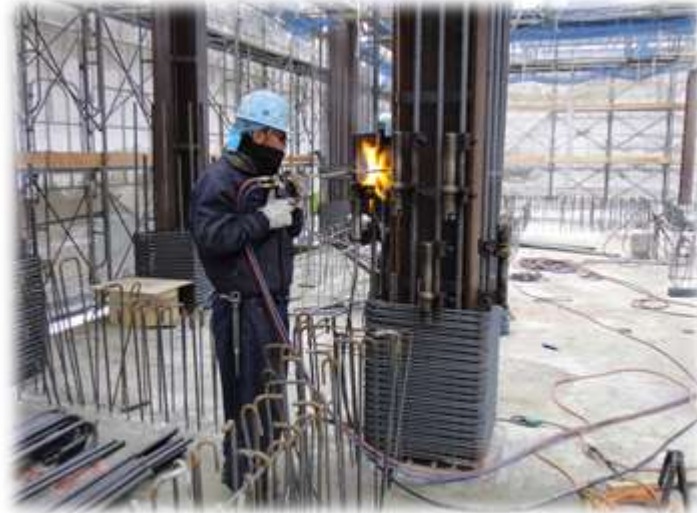
A工区① 1階柱鉄筋圧接状況
