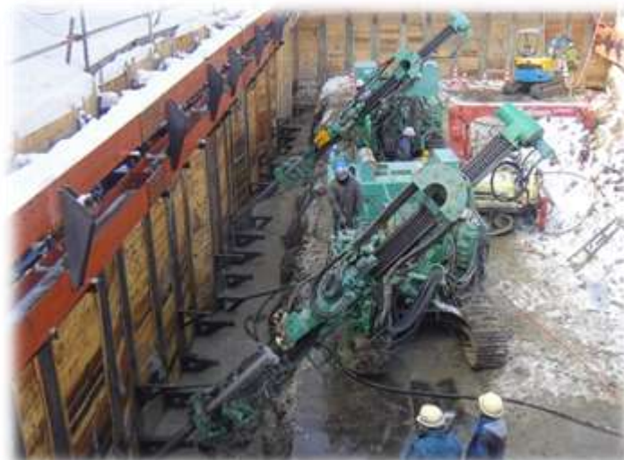
B工区 山留アースアンカー設置状況
