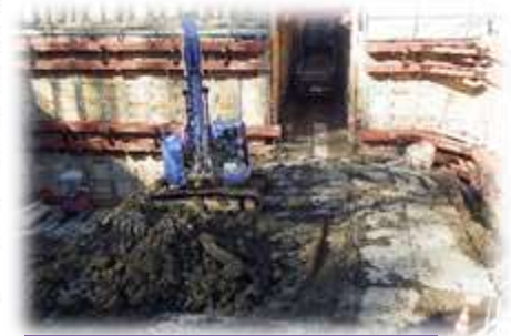
掘削土搬出状況
