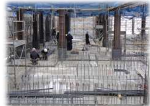
炉室1階 作業状況
