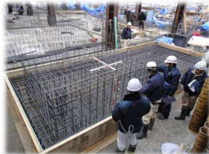
A工区② 蒸気タービン基礎配筋検査状況
