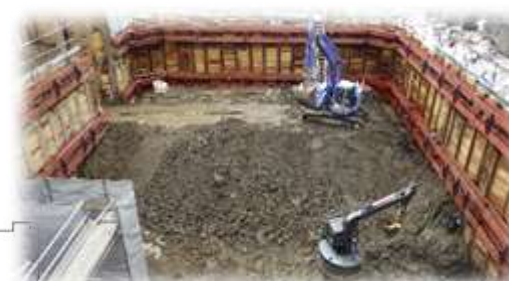
ごみピット部分の掘削状況
