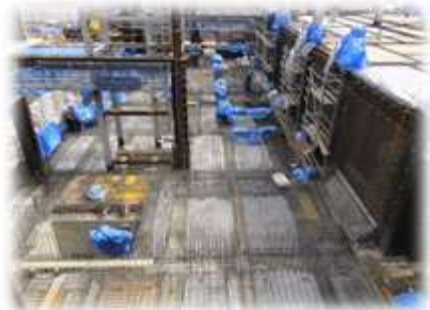
炉室1階 鉄筋・型枠工事状況
