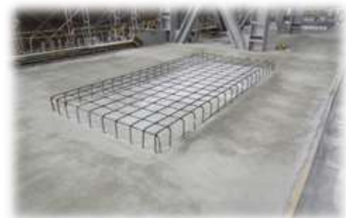
炉室2階床 完成
