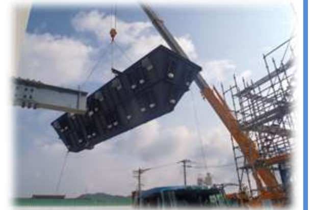
プラント機器据付工事(イメージ)
