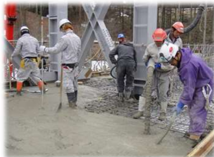
A工区①②2階コンクリート打設状況
