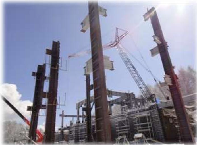
A工区①② 鉄骨第2段階建方状況
