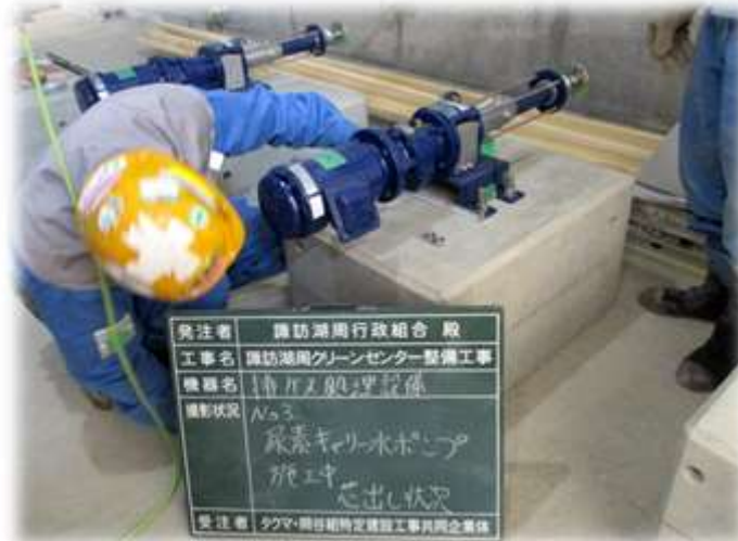
A工区 ポンプ据付状況
