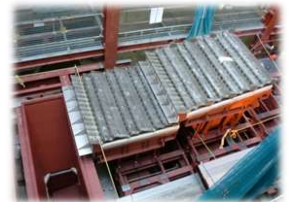
ストーカ据付工事(イメージ)
