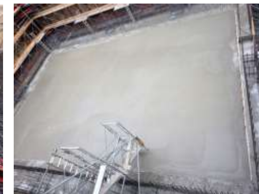
ごみピット底盤コンクリート打設完了
