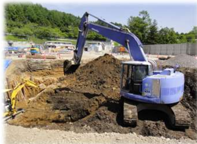
C工区 掘削工事状況
