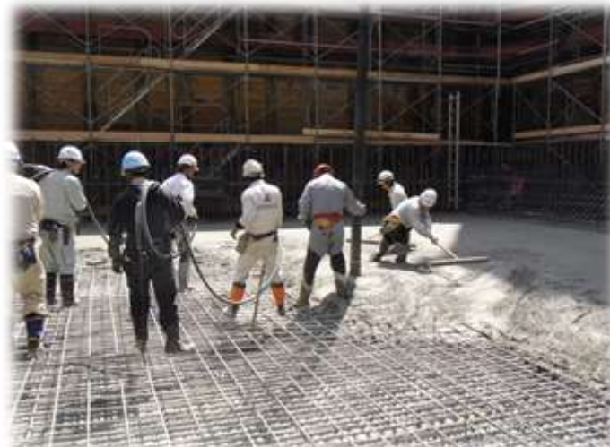
B工区 ごみピット底盤コンクリート打設状況
