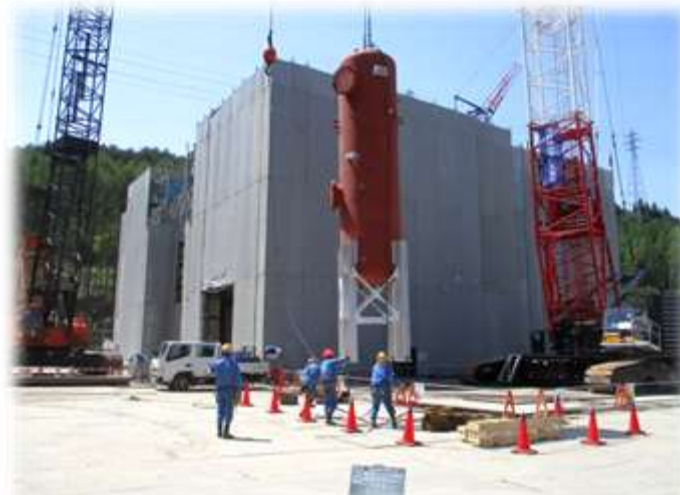
A工区 脱気器据付状況
