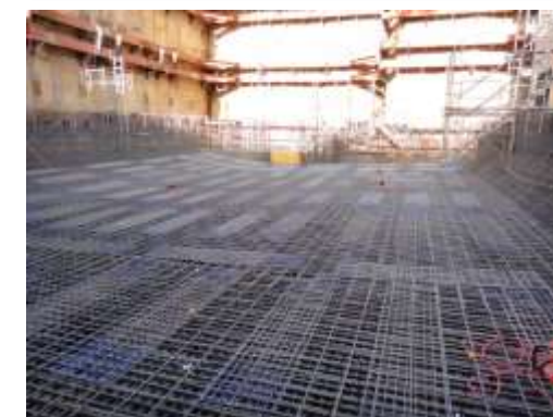
ごみピット底盤配筋状況
