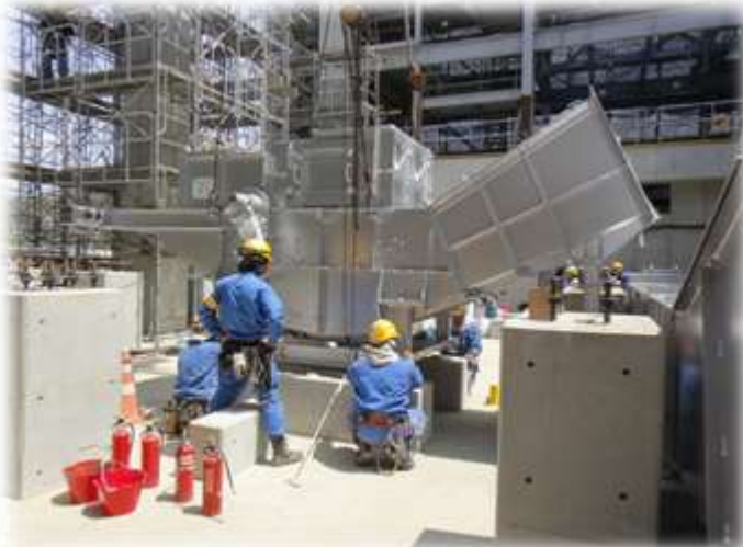
A工区 灰搬出装置据付状況
