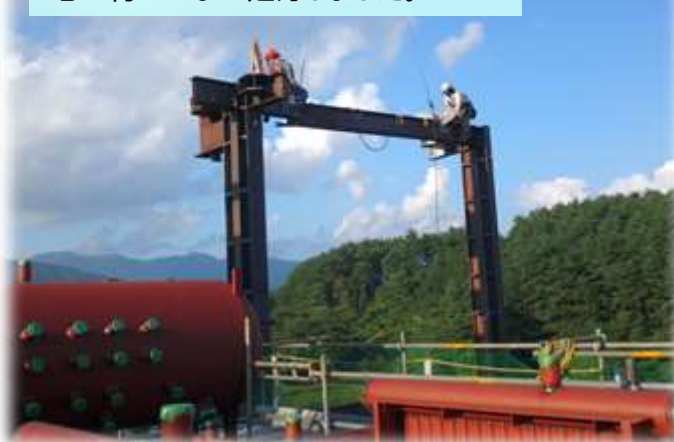
B工区 鉄骨建方状況
