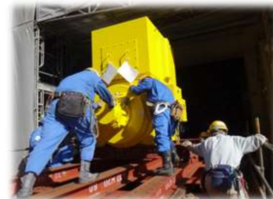
非常用発電機据付工事(イメージ)
