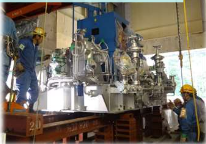
蒸気タービン据付状況
