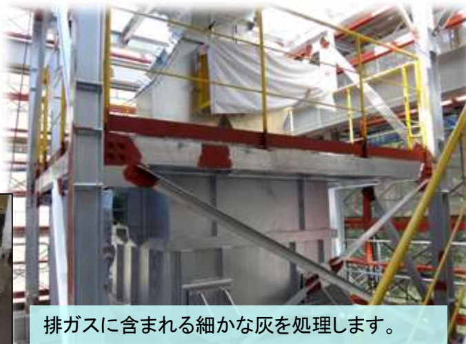
飛灰処理設備 据付状況
