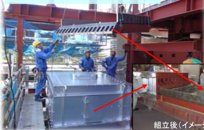
給じん装置 据付状況
