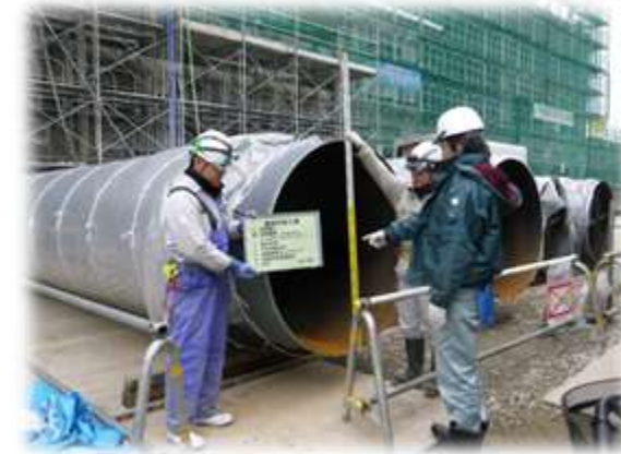
煙突内筒工事(イメージ)
