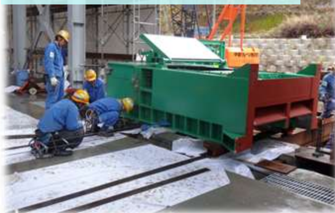
切断機 据付状況
