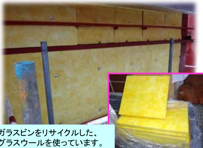
ろ過式集じん器保温材施工状況
