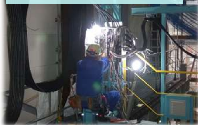
灰クレーン 電気工事施工状況
