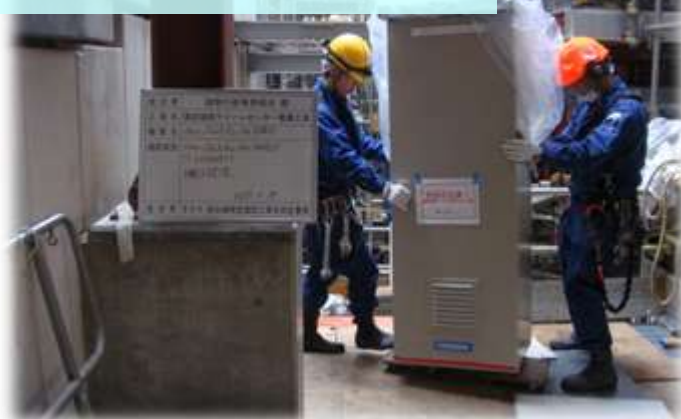
排ガス分析計 据付状況
