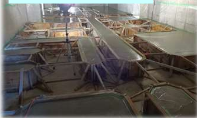
高圧電気室 ケーブルピット打設状況
