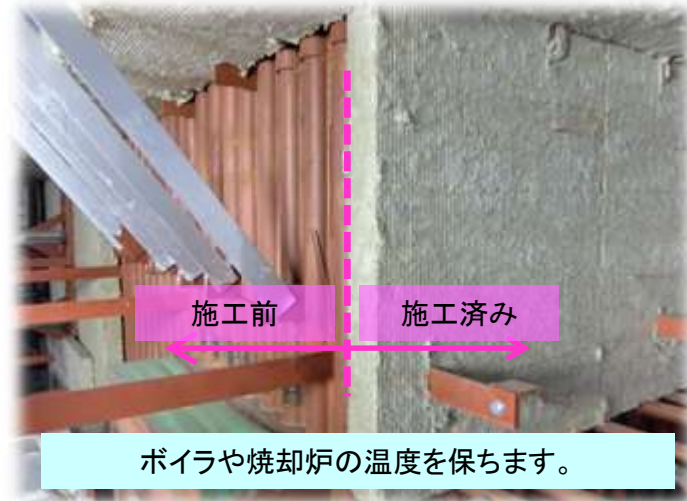
保温工事 施工状況
