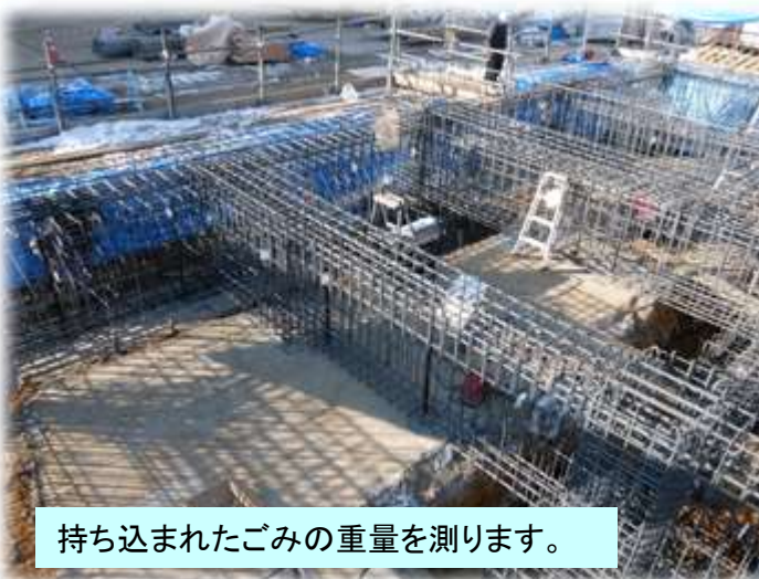
計量棟配筋工事状況
