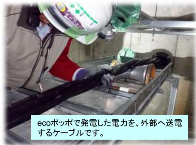
ecoポップで発電した電力を、外部へ送電するケーブルです。
