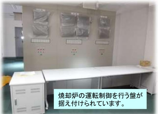
焼却炉の運転制御を行う盤が据え付けられています。
