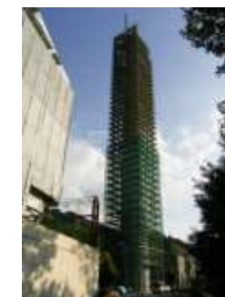
煙突仮設足場設置(イメージ)
