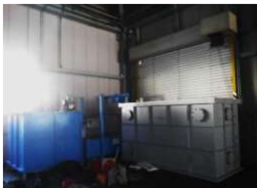
排水処理装置設置
