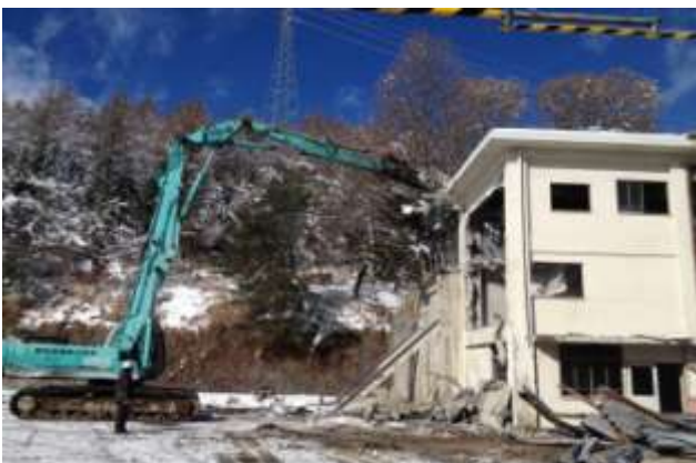
旧厚生棟解体状況
