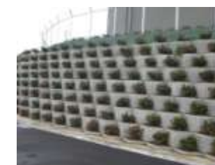
植生ブロック工事(イメージ)
