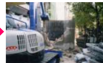
輪切りにしたコンクリートをクレーンで地上に降ろした後、重機にて解体します
