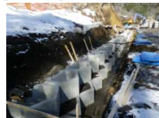
植生ブロック施工状況
