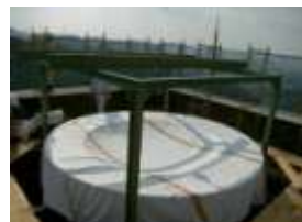
飛散防止のため開口部の養生を行います
