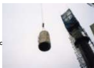
煙突解体(イメージ)
