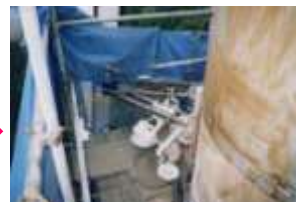
ダイヤモンド入りのワイヤーを高速回転させて煙突を切断します
