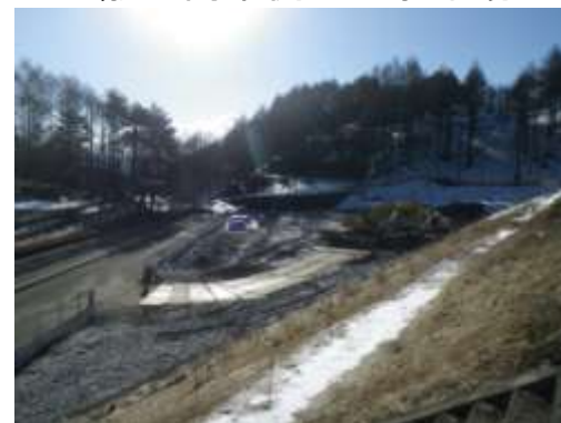
盛土工施工状況
