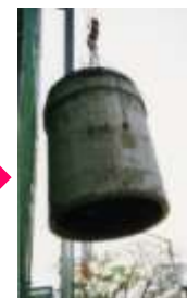
輪切りにしたコンクリートをクレーンで地上に降ろした後、重機にて解体します
