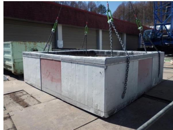
クレーンでつり上げられていた煙突(外筒)の一部です。コンクリート片は、幅が4.5m×4.5m、高さ1.4mで、重さが10.8tあります。
