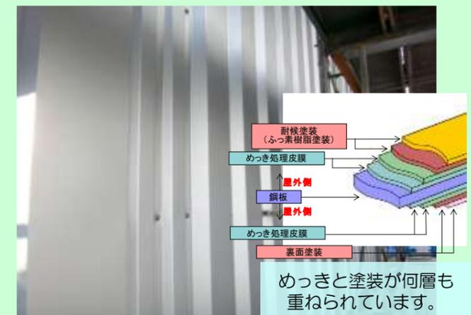
外筒鋼板は、フッ素樹脂で塗装された耐久性の高い資材を使用しています。
