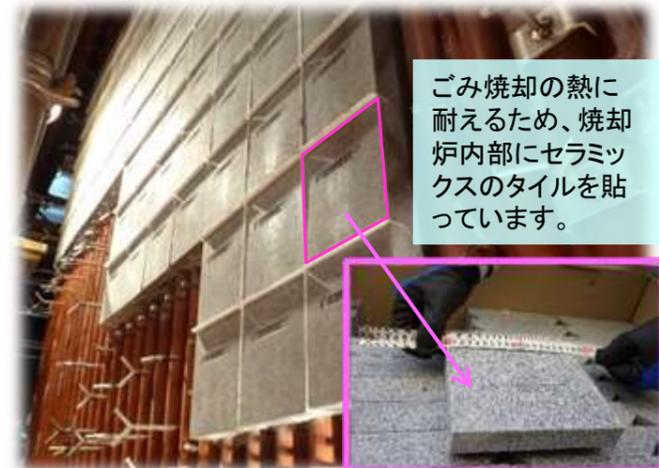
ごみ焼却の熱に耐えるため、焼却炉内部にセラミックスのタイルを貼っています。
