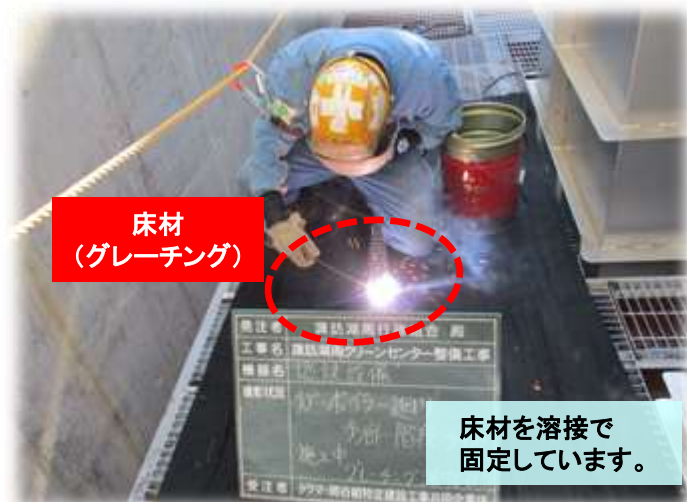
A工区 炉室点検歩廊取付状況
