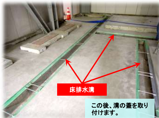
A工区 床排水溝完成
