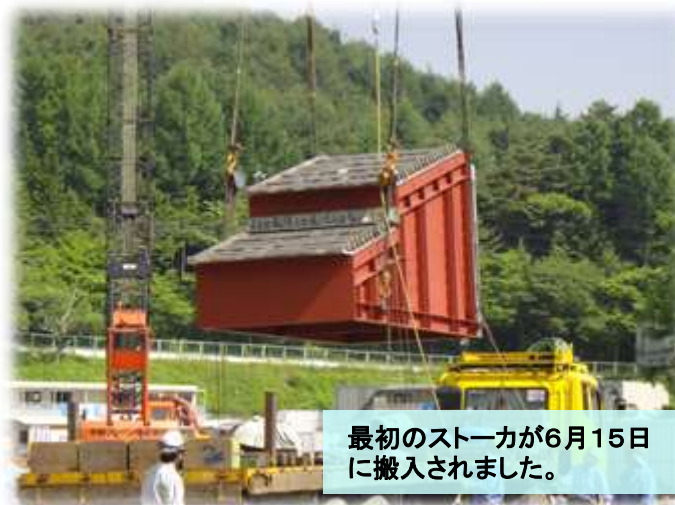
A工区 燃焼・後燃焼ストーカ搬入状況
