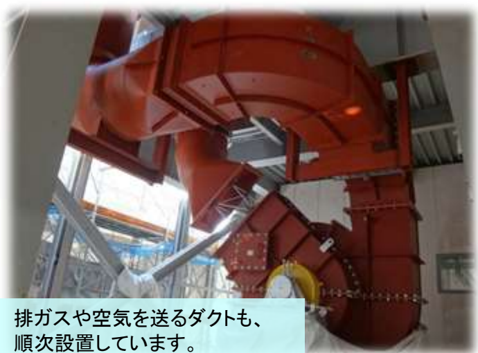
A工区 誘引送風機ダクト接続状況
