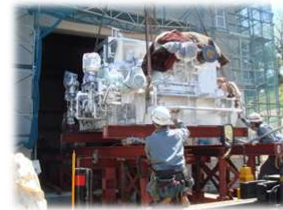
蒸気タービン据付工事(イメージ)
