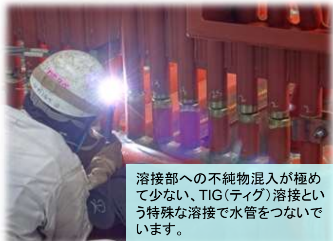
A工区 ボイラー水管溶接状況
