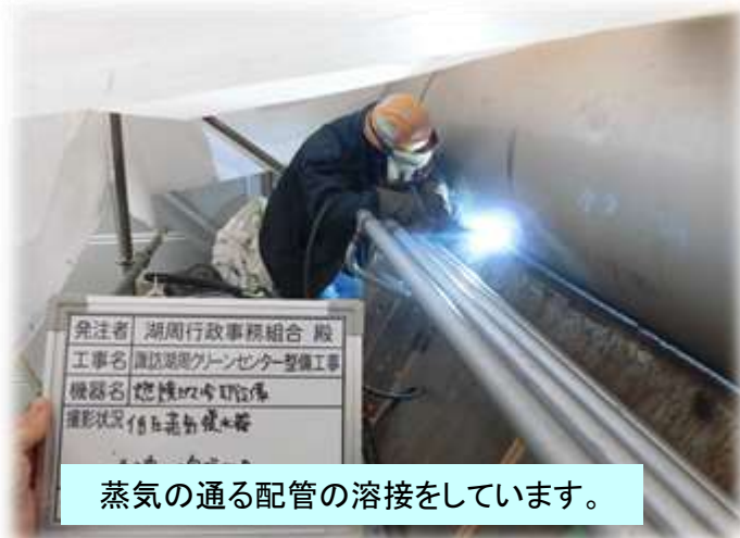
蒸気復水器 施工状況
