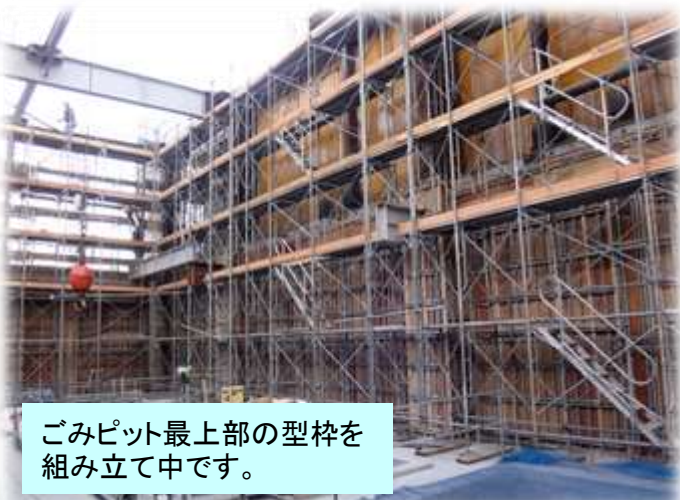
ごみピット壁 型枠施工状況
