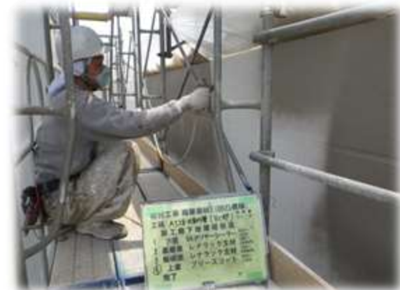
外壁工事(イメージ)
