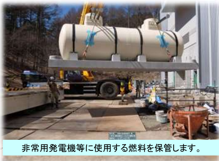
助燃油貯槽据付工事状況
