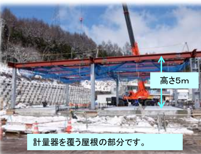
計量棟鉄骨工事状況
