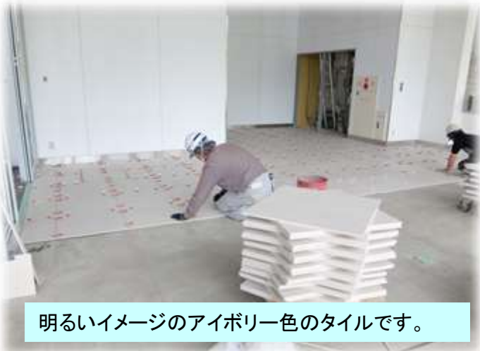
正面玄関 床タイル施工状況
