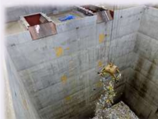
ごみピット攪拌(かくはん)状況
