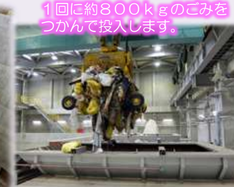
1号ごみクレーン ごみ投入状況
