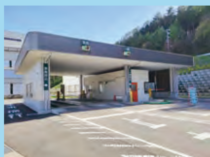
ごみの重さを計る計量棟
