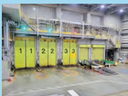
ごみを受け入れるプラットホーム
